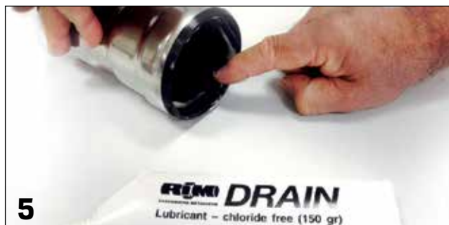
5 Lubrificazione zona interna guarnizione / Internal gasket lubrication
